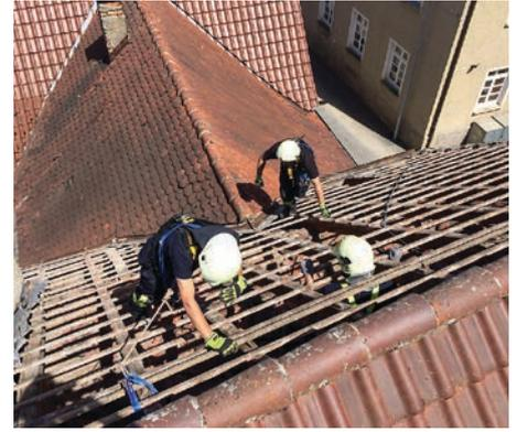
Arbeiten zur Dachsicherung, richtig gesichert – kein Problem für die Feuerwehr.
